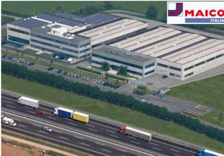
La nuova sede di Maico Italia SpA a Lonato del Garda (BS): l'impianto fotovoltaico da 65Kw copre il 50% dei fabbisogni energetici di Maico Italia.
